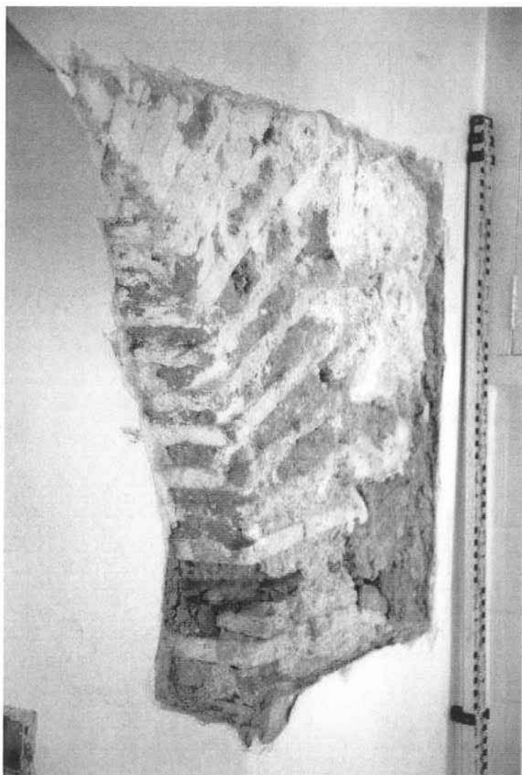
Paramento exterior del arco UEM 419 y la fábrica de mampostería UEM 418
