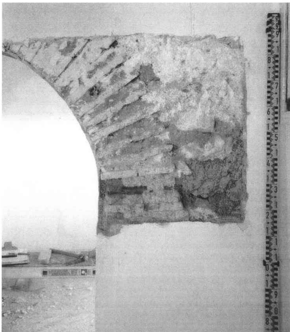
Paramento exterior del arco UEM 419 y la fábrica de mampostería UEM 418
