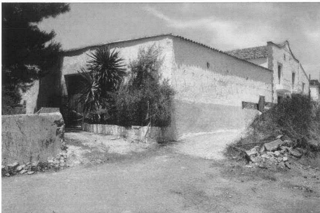
Vista exterior del área de patio (6)
