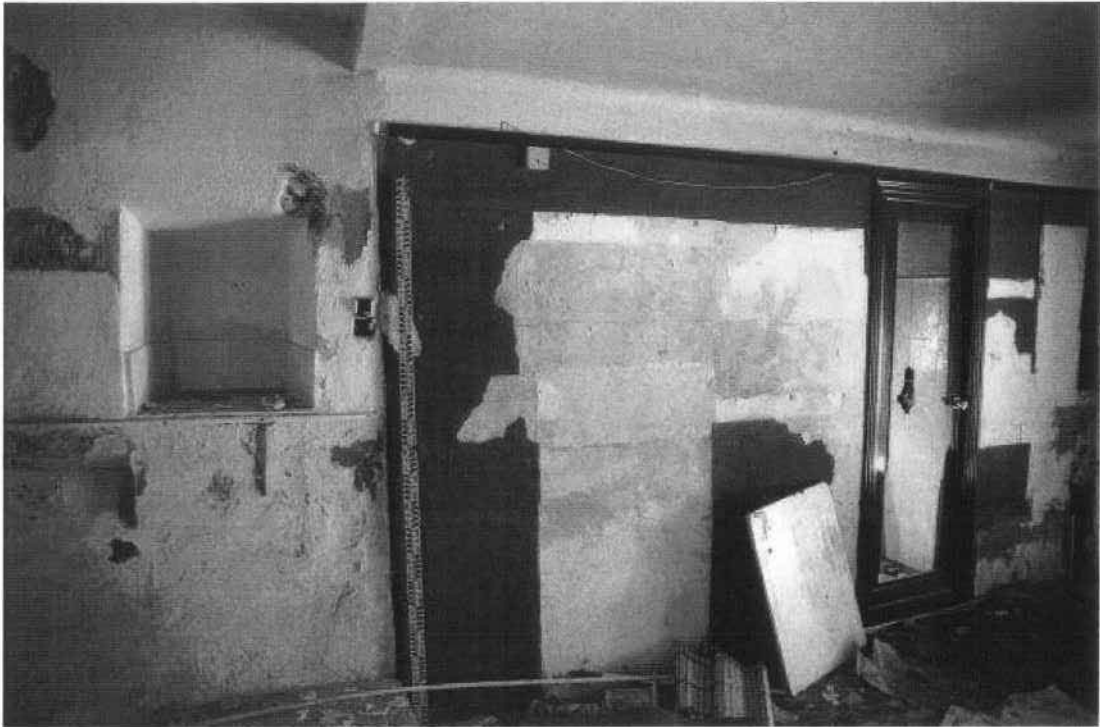
Estado inicial del paramento sur del muro de la antigua fachada principal. Cata 7
