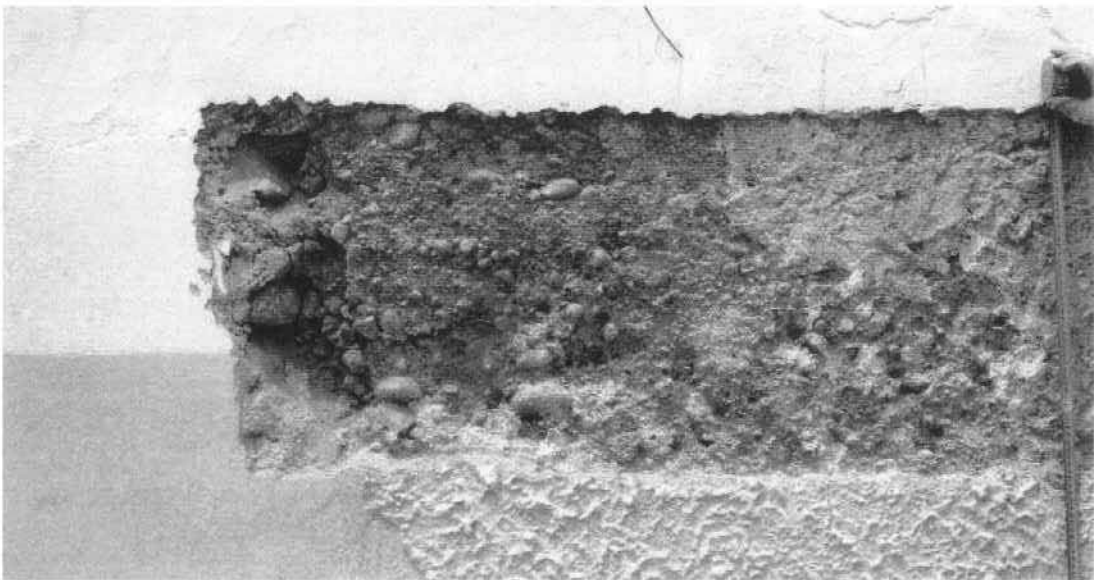
Detalles del muro de tapial 110. Imagen superior sección donde se aprecia su composición de tierra batida. Imagen inferior paramento con costra de hormigón
