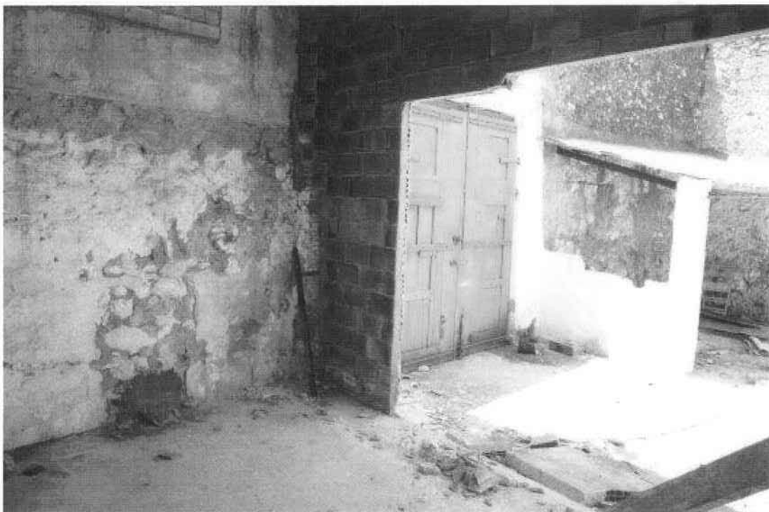
Cuadra o porchada del patio 6
