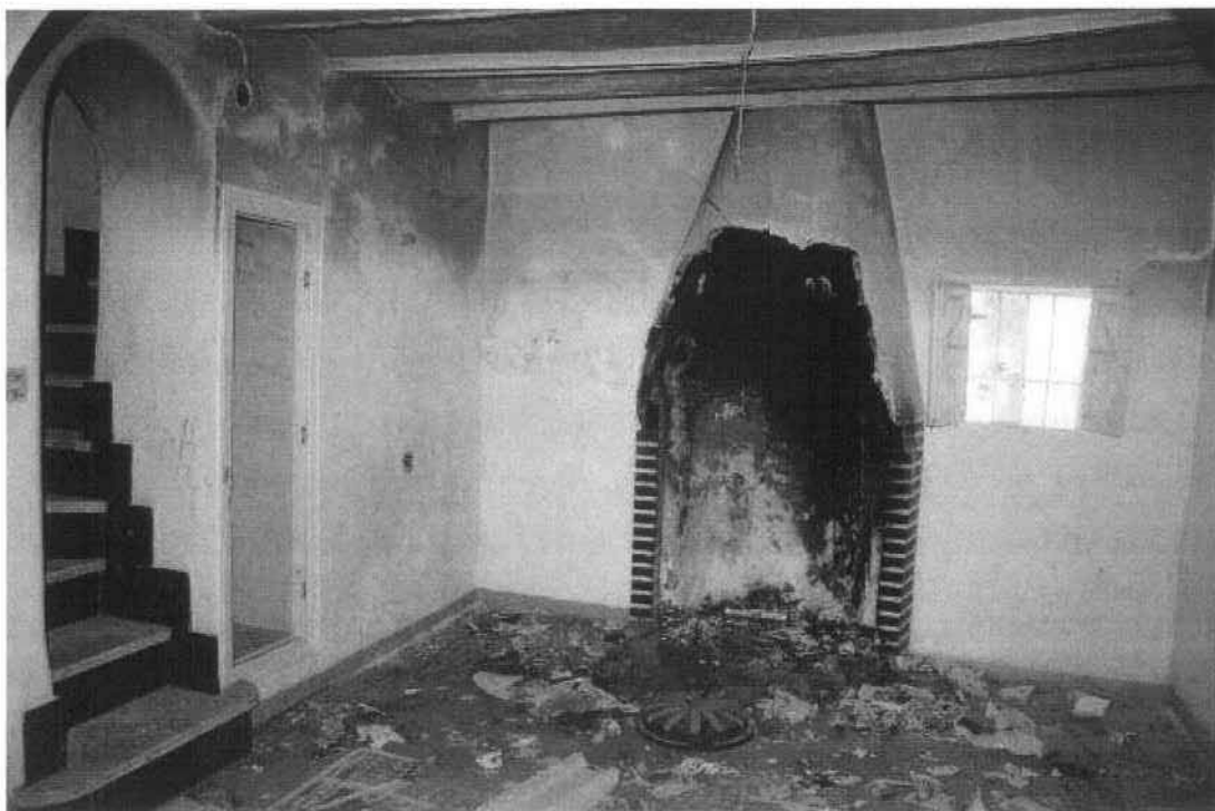
Interior del cuerpo 1B, donde se aprecia el suelo de terrazo, las antiguas bovedillas de forjado y la escalera de nueva creación
