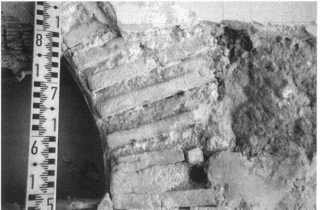
Detalle del antiguo arco y fábrica de mampostería asociada
