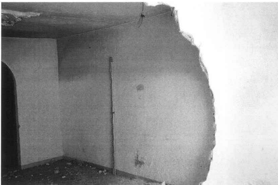
Situación inicial del paramento
