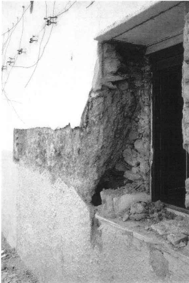
Vista general del área estudiada donde se aprecia el muro de tapial 110, cortado para la construcción de una ventana
