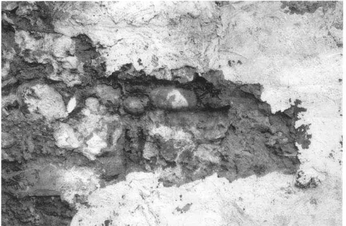
Detalles de la cata 2, donde se aprecia la fábrica de mampostería
