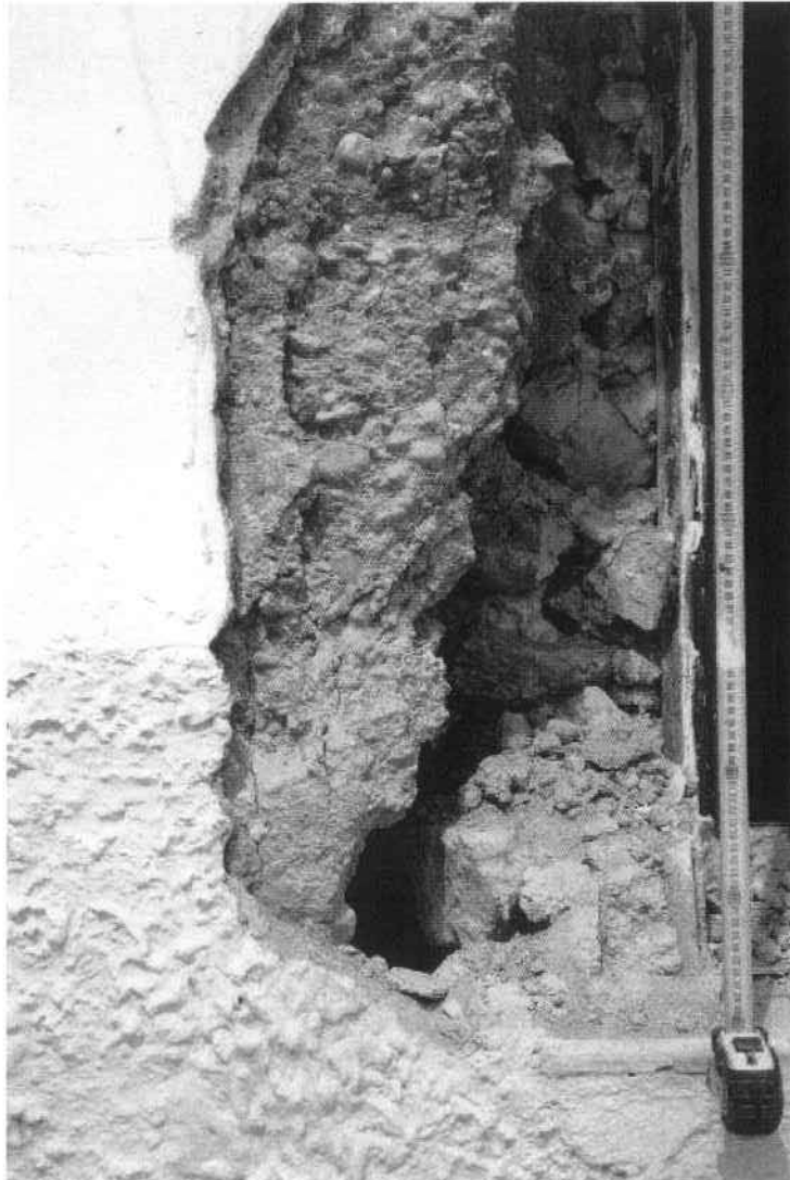
Detalle de la rotura de la fábrica original 110 para la construcción de una ventana
